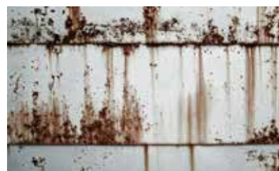
Beschermen tegen roest en corrosie
