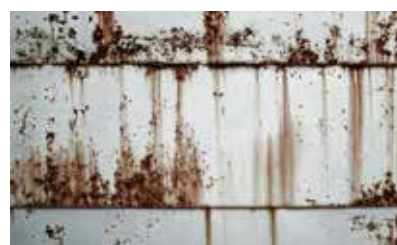
Empêcher la formation de rouille et la corrosion
