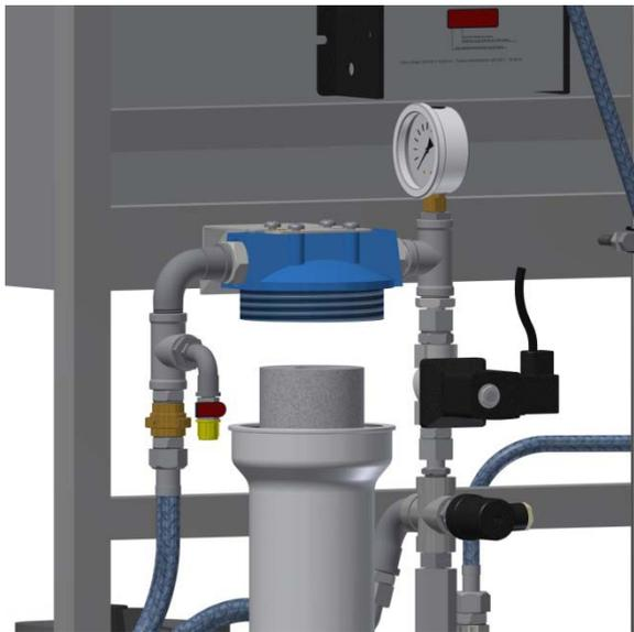
Fig. 52: Installation du filtre d'entrée
